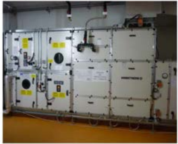
Lüftungsanlage 7.250 m 3 / Stunde
