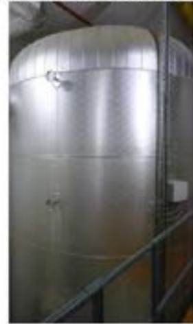
Wärmespeicher der Heizzentrale 23 m 3
