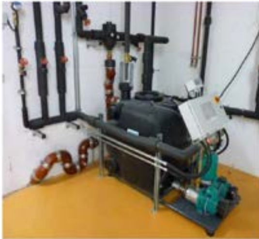
Regenwasserdruckstation
