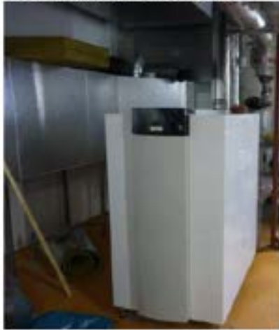
Brennwertkessel thermisch 539kW
