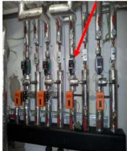
Heizungsverteiler mit Hocheffizienzpumpen
