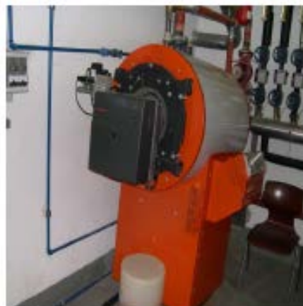
Brennwertkessel
